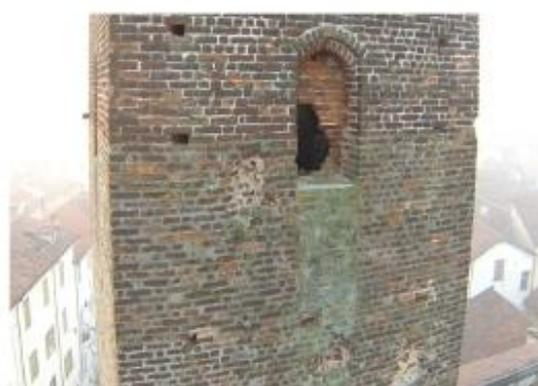
FIGURA 5: PARTICOLARE PROSPETTO NORD CON EVIDENZA DEL GRADO DI ABBANDONO IN CUI VERSA LA STRUTTURA CON COPIOSE ZONE COPERTE DA MUSCHI E LICHENI. SONO ANCORA VISIBILI I SEGNI DELLE CANNONATE DEL 1704.
